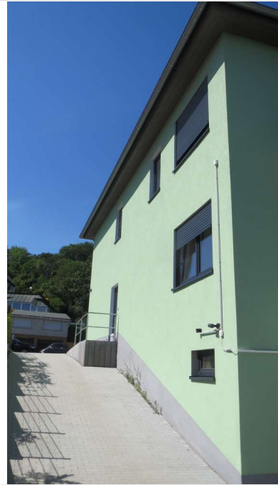
Giebel West Hauseingang
