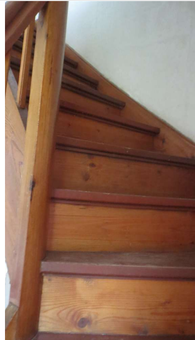
EG Treppe zum DG
