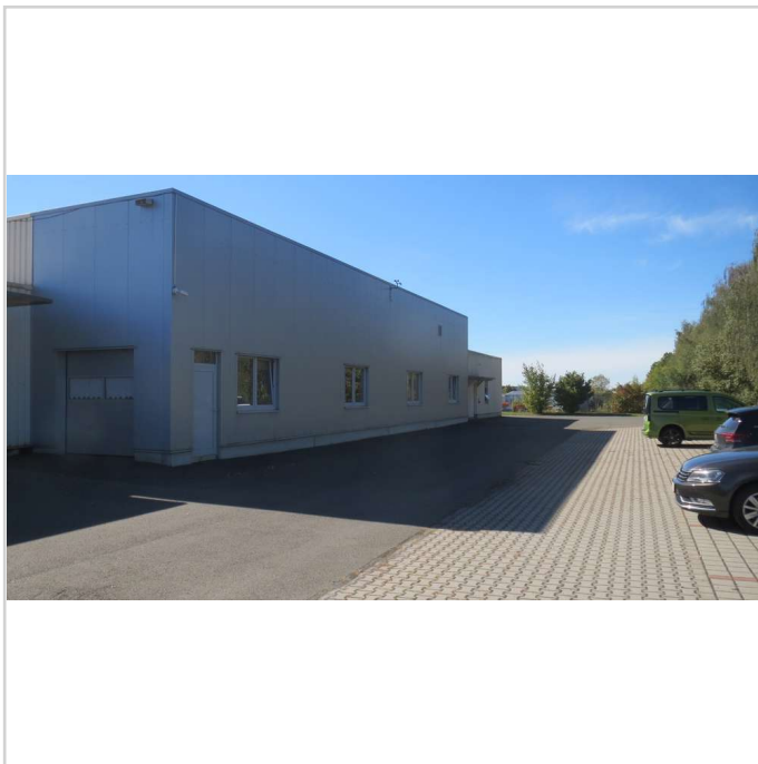
Rückansicht mit Anbau
